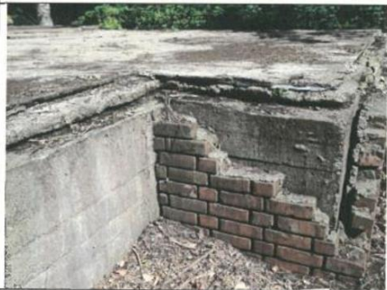
Bild 3: Außenmauer – keine vertikale Schwarzabdichtung sichtbar (bis ca. 50cm im Erdreich geöffnet)
