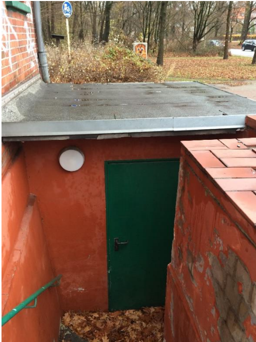
Zu 4. Trafohaus von Borsteler Chaussee – Niedergang zu Keller Alsterkrugchaussee (Foto J. Bönig 2018)
